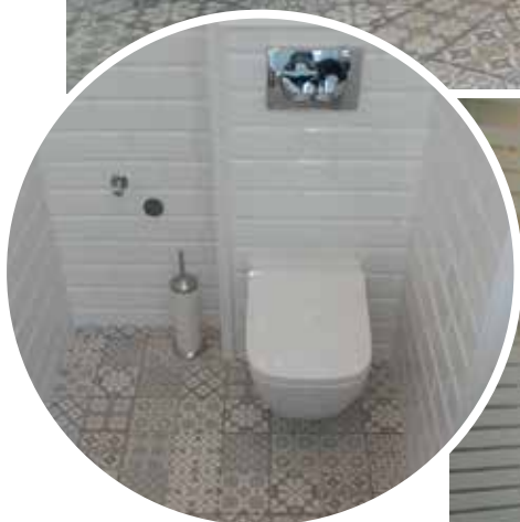
Okładziny zostały zafugowane spoinami z linii ATLAS Artis.
