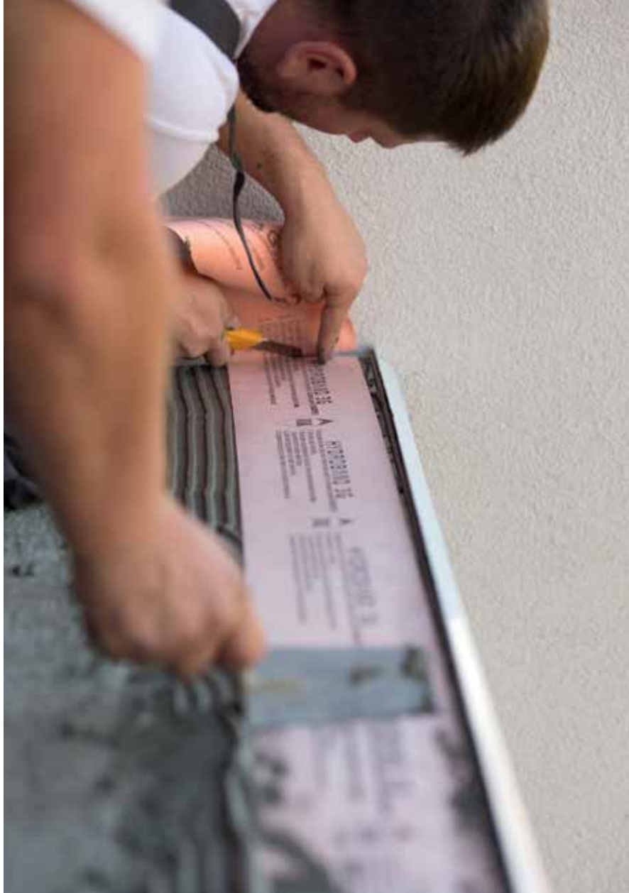
Taśmy i manszety podczas prac na tarasach należy montować przed przyklejaniem płytek.
