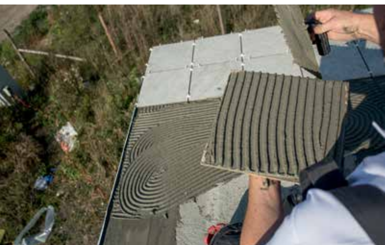
Plus S2 Hydro można stosować jako klej oraz hydroizolację na tarasie w jednym cyklu technologicznym.
