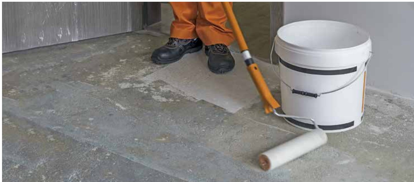
Gruntowanie jest potrzebne w przypadku układu zespolonego, czyli wykonywanego bezpośrednio na podłożu mineralnym, np. na płycie betonowej lub żelbetowej.
